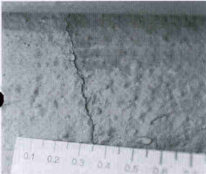
Bild 14a. Kontrollriss Kärcherhalle Westseite vor den Sprengungen
