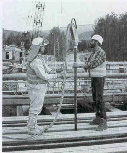
Bild 6. Herstellen der Bohrlöcher mit dem Hochdruckwassergerät
