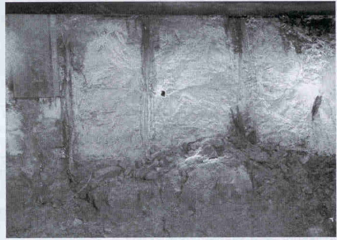
Bild 9d. Deutliche Bohrlochspuren nach dem Beräumen der Sprengstelle
