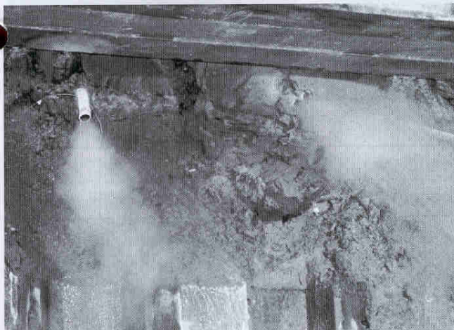
Bild 9c. Austritt von Stickstoffdämpfen aus den Gefrierrohren nach dem Sprengen
